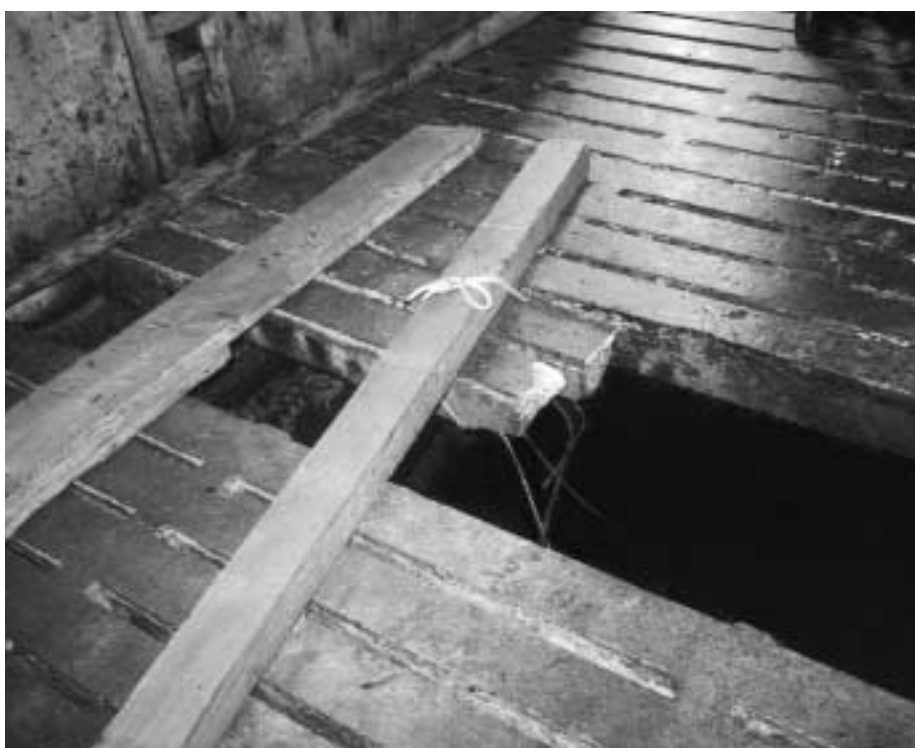
Fig. 1: La rupture soudaine d'anciens éléments caillebotis peut entraîner des accidents mortels (photo Roman Euler, SAB).
