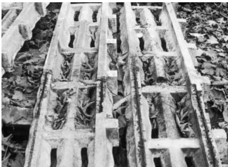
Fig. 10: Vue de dessous des éléments 18 (à gauche) et 19 (à droite) après l'essai de charge. Sur les deux éléments, la barre d'armature est arrachée dans la poutre gauche.
