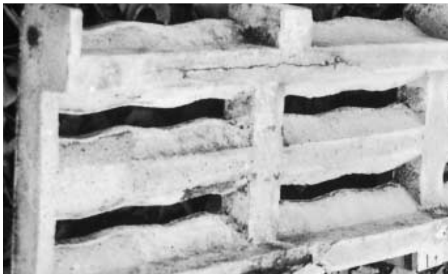
Fig. 2: Fissures horizontales très nettes, dessous, à l'extrémité de l'élément, signes avant-coureurs de la désolidarisation de la barre d'armature et du revêtement en béton.
