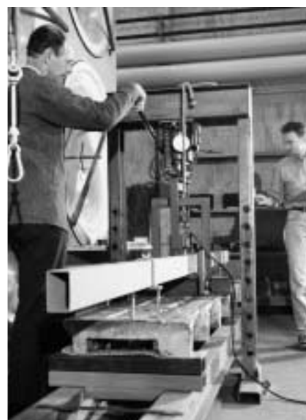
Fig. 8: Installation d'essai pour les essais de charges sur les éléments caillebotis en béton.
